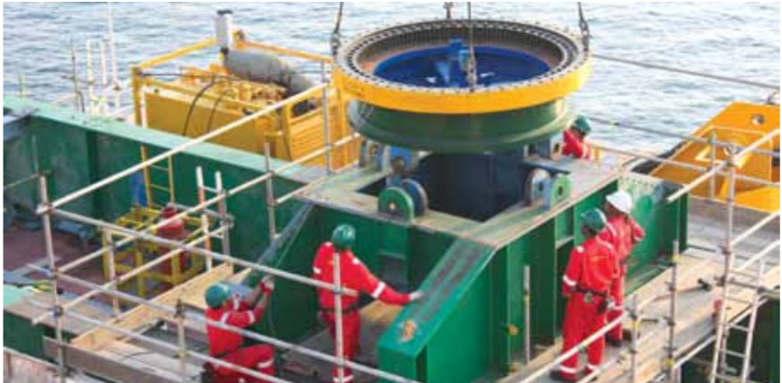
مفاعل الغاز المتقدم ١ – عملية استخراج مجموعة أنابيب جهاز تبريد الغاز
