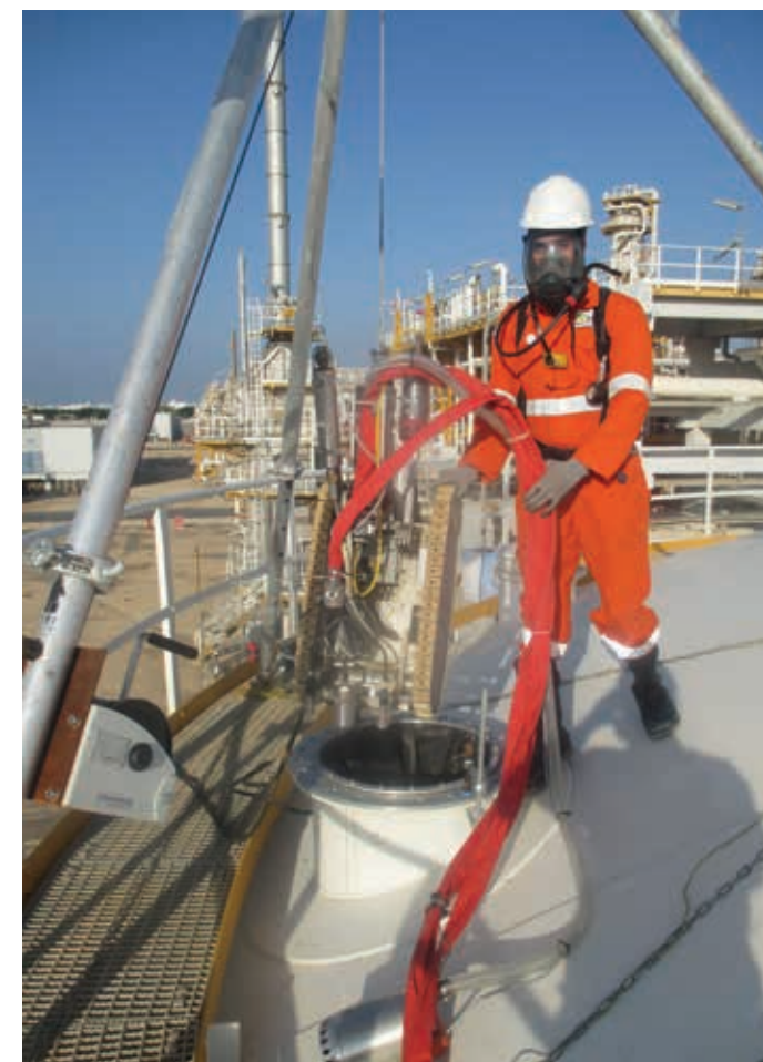
ادخال الفحص الآلي بالروبوت داخل خزان الامينات من الاعلى
