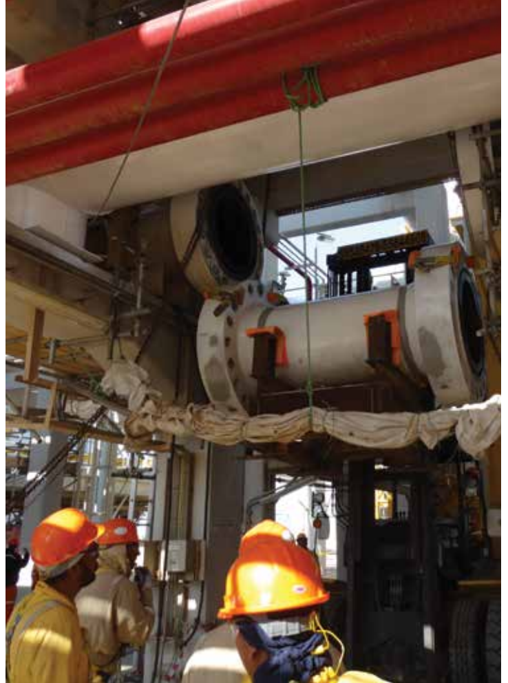
تركيب أبواب، قطر ٣٤ إنش، والذي يصل الضاغط بخط الأنابيب الرئيسي
